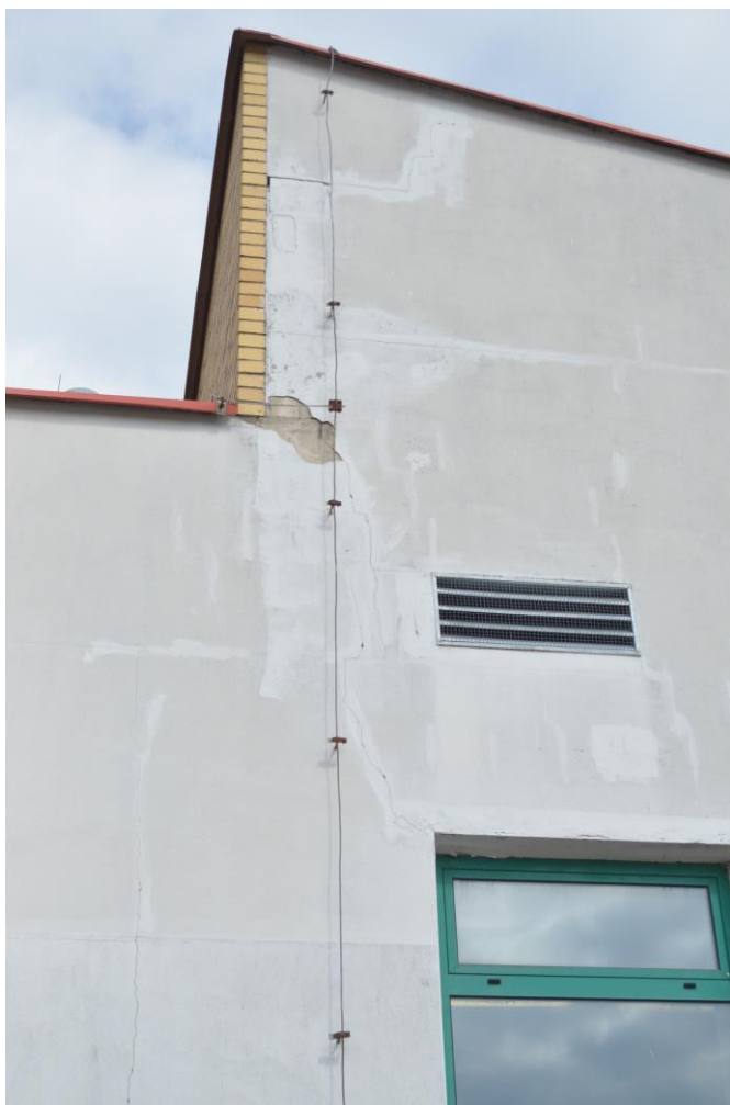
Fot. 1 Elewacja zachodnia – widoczne uszkodzenia tynku i pęknięcia zewnętrznej warstwy ściany warstwowej.
